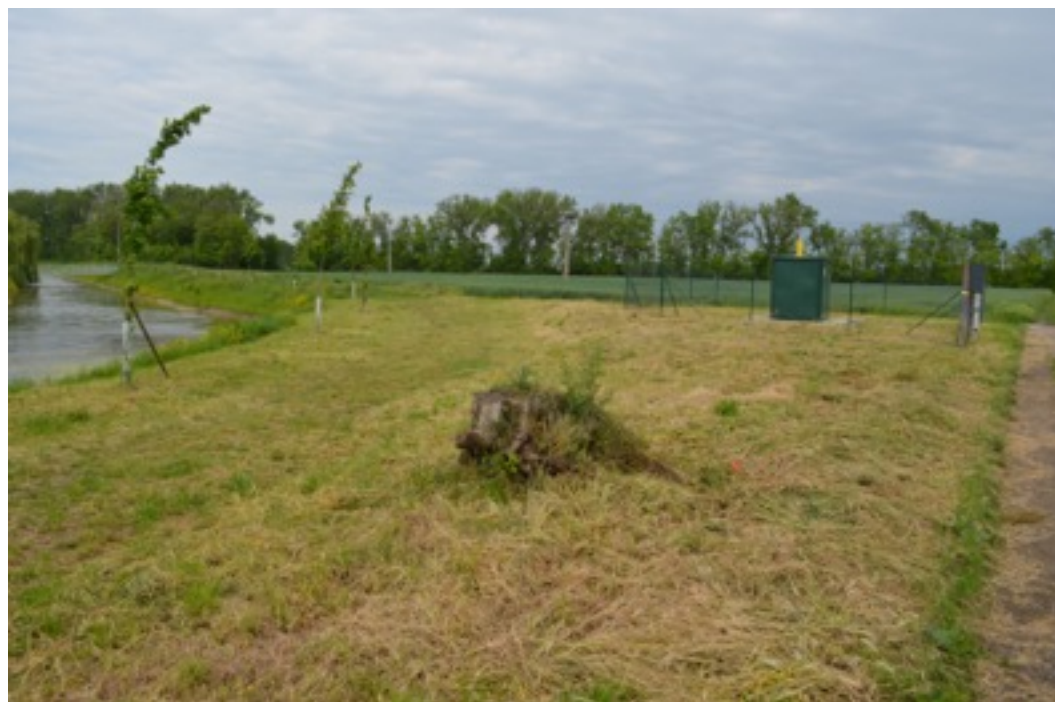
Regulační stanice, vlevo VKP Měnínská tůň (jaro 2016)
