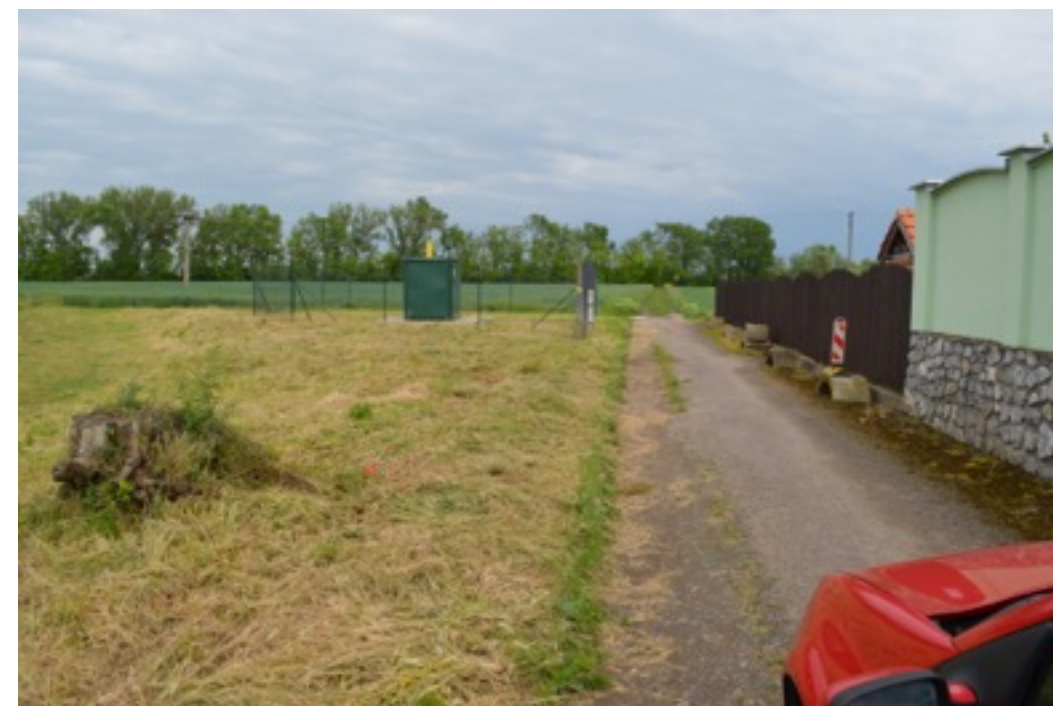
Regulační stanice VTL/NTL, přístupová účelová komunikace (jaro 2016)
